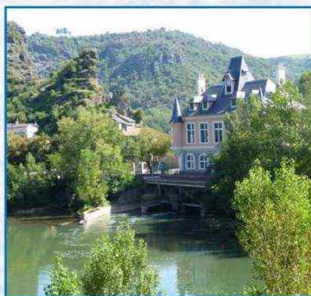
Micro centrale électrique d'Ambialet sur le Tarn
