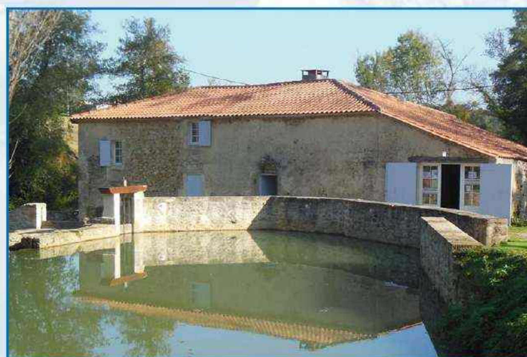
Moulin de Pinquet à Saint-Félix de Foncaude: la vanne de régulation du débit est visible à gauche.
