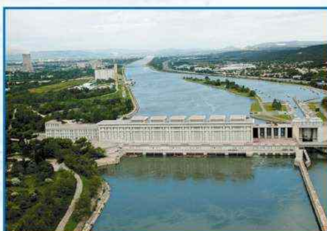
Barrage et usine hydroélectrique de Donzère-Mondragon sur le Rhône
