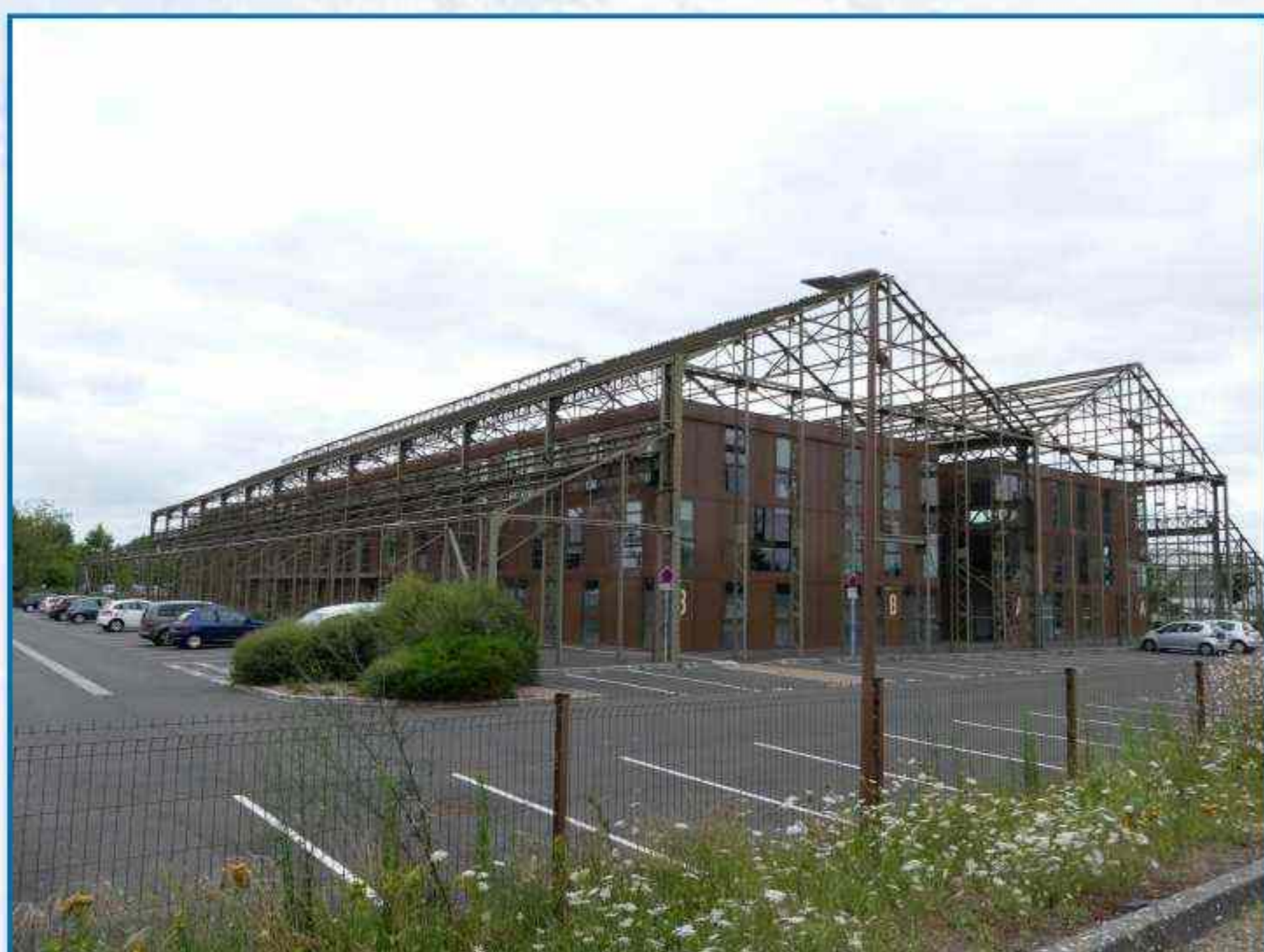
Réhabilitation en 2015 des immenses hangars de l'usine d'aviation Louis Blériot construits à Bègles en 1918
