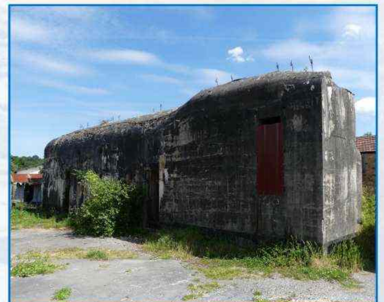
Un des bunkers de La House
