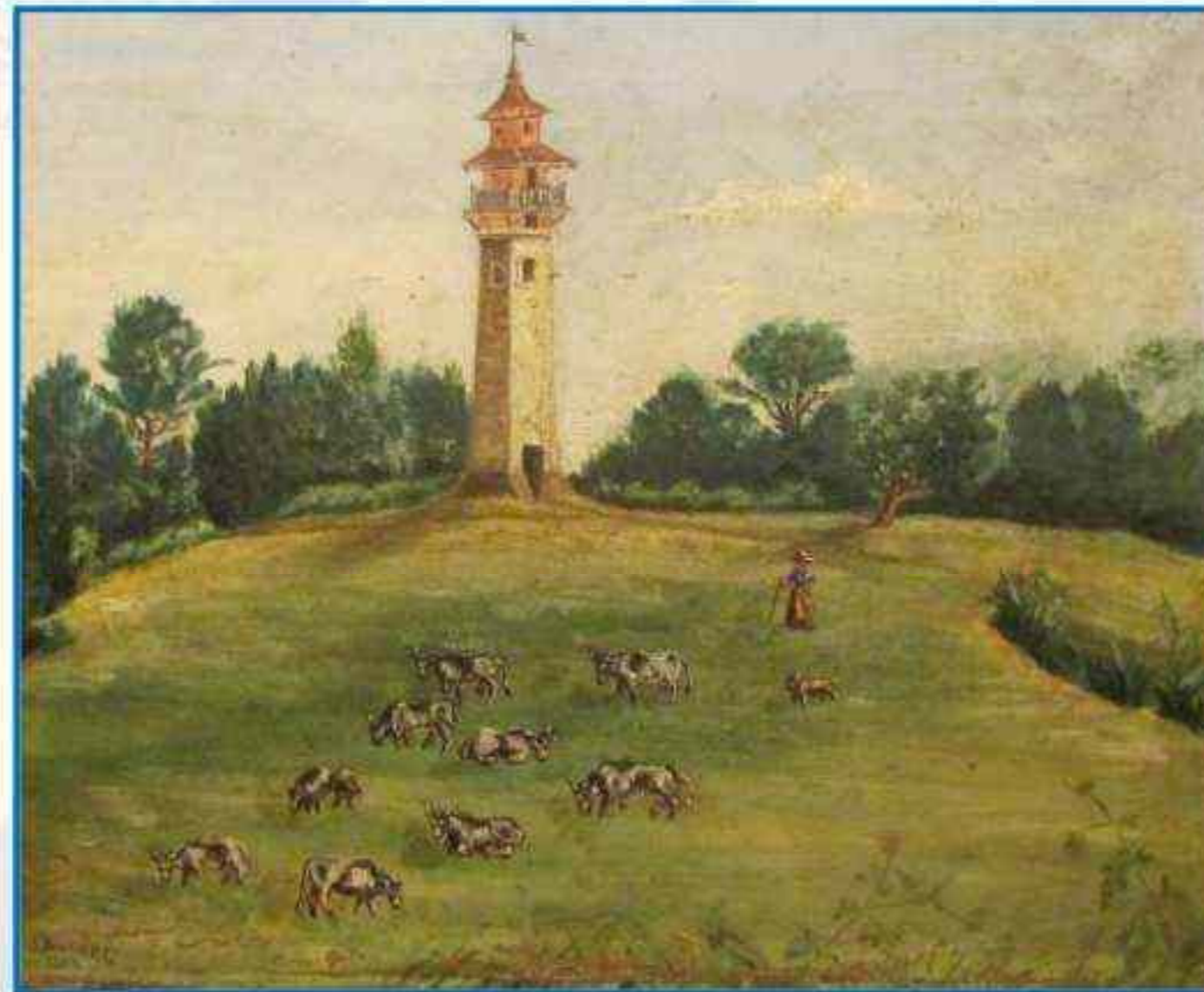
La tour de Fourc (la fourche) située au confluent de l'Eau Bourde et de l'Estey des Sources à Cestas était d'abord un site de surveillance. Elle a été détruite en 1900.
