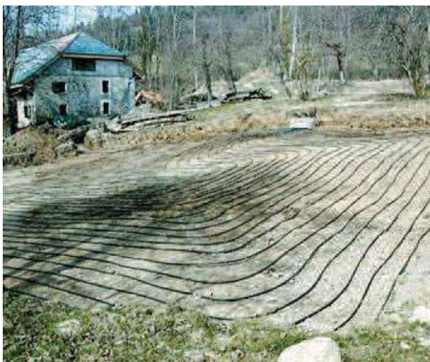
© Viessmann - Réseaux de capteurs horizontaux en polyéthylène enterrés à faible profondeur dans lequel circule le fluide caloporteur jusqu'à la pompe à chaleur.
