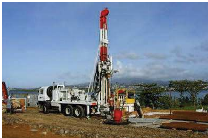
Crédits BRGM - Machine de forage
