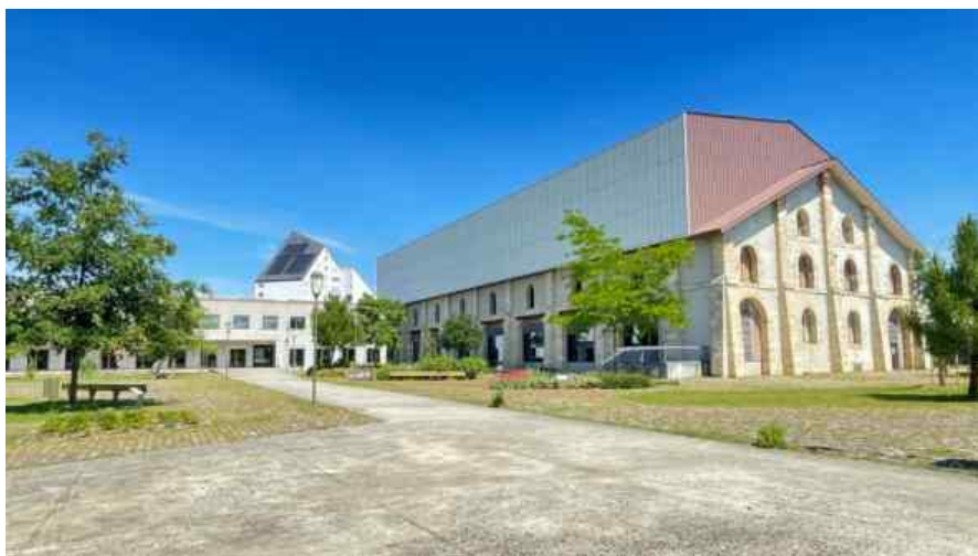
Le bâtiment des archives de la Métropole.
