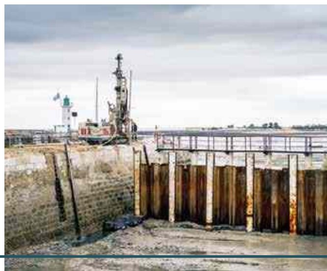
Construction du combiwall qui permet d'isoler la zone de chantier et de travailler à sec à toute heure de la journée
