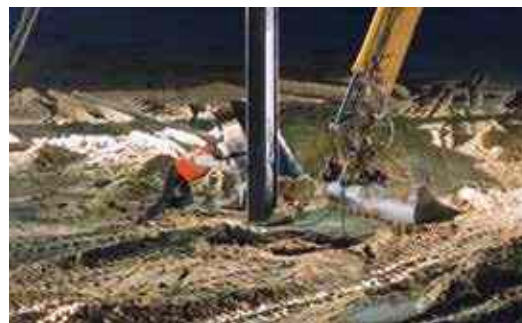
Mise en place du batardeau
