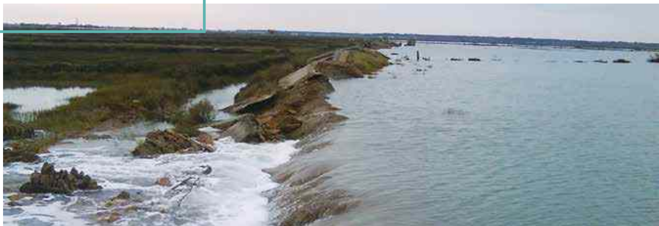
Submersion marine par surverse
