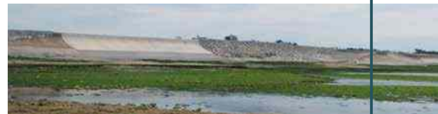
Secteur du Nouleau, digue vue de l'estran, état actuel
