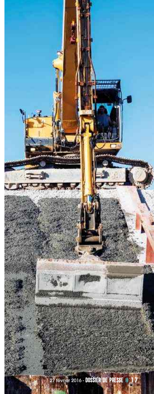
Travaux Digue du Boutillon
