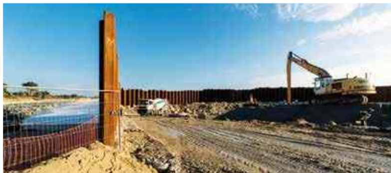
Digue du Boutillon
