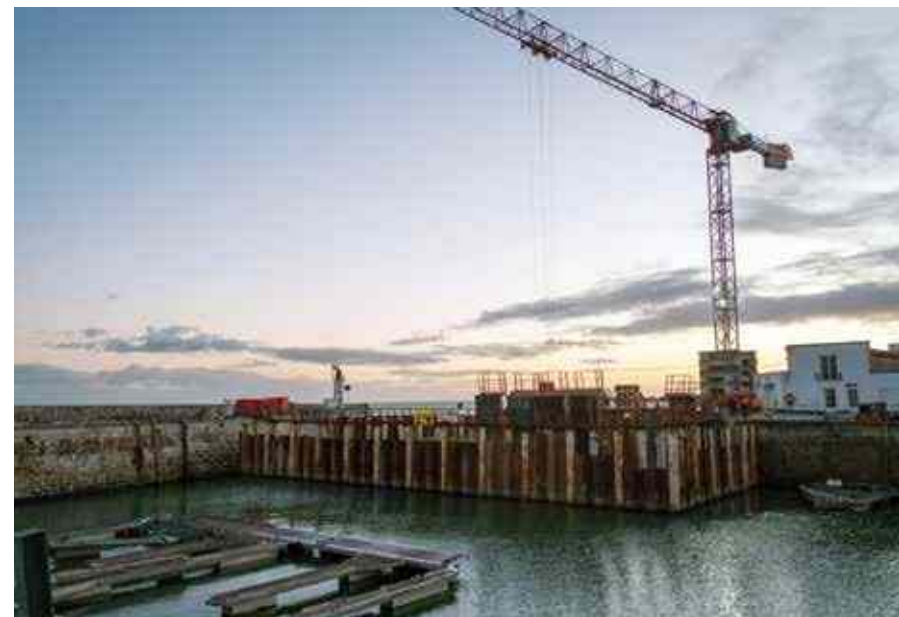
Chantier du port de La Flotte
