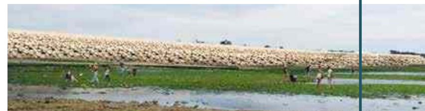
Secteur du Nouleau, digue vue de l'estran, projection après travaux
