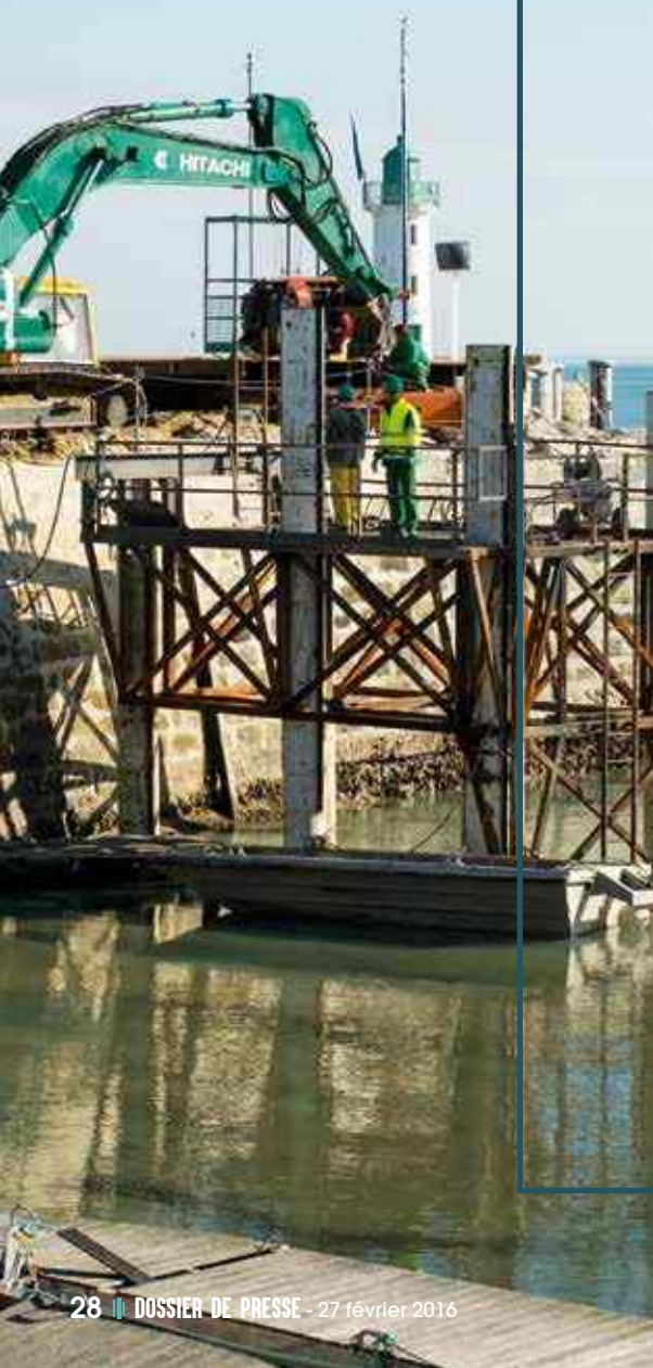
Construction du combiwall qui permet d'isoler la zone de chantier et de travailler à sec à toute heure de la journée
