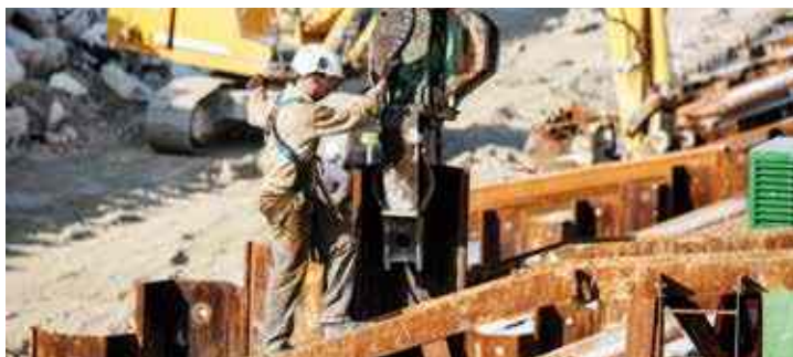
Mise en place du batardeau
