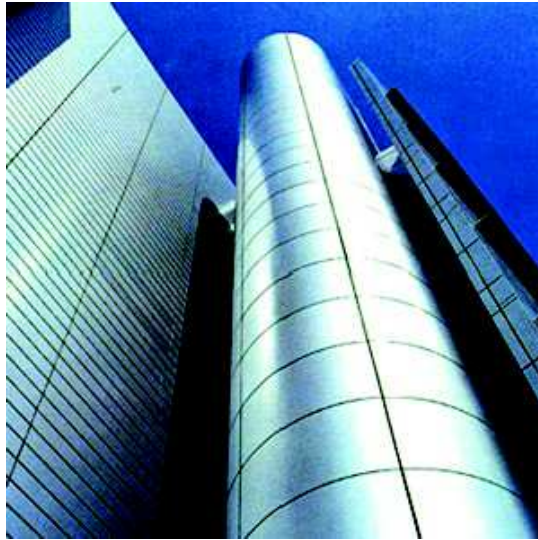
Immeuble en aluminium
